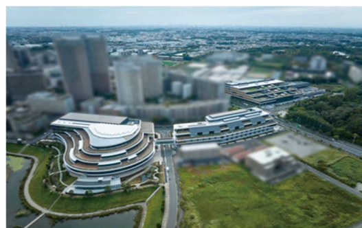
Japan Technical Center A・B・C 棟 全景 （千葉県柏市）
